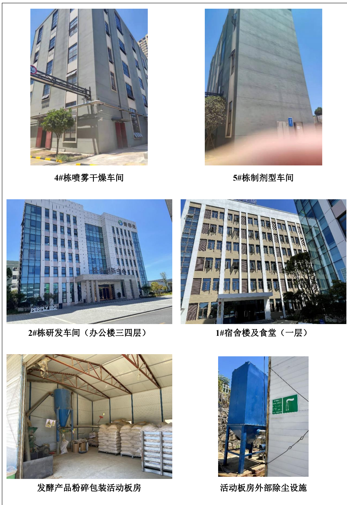
图 3.1.4-1 各生产厂房建设情况
