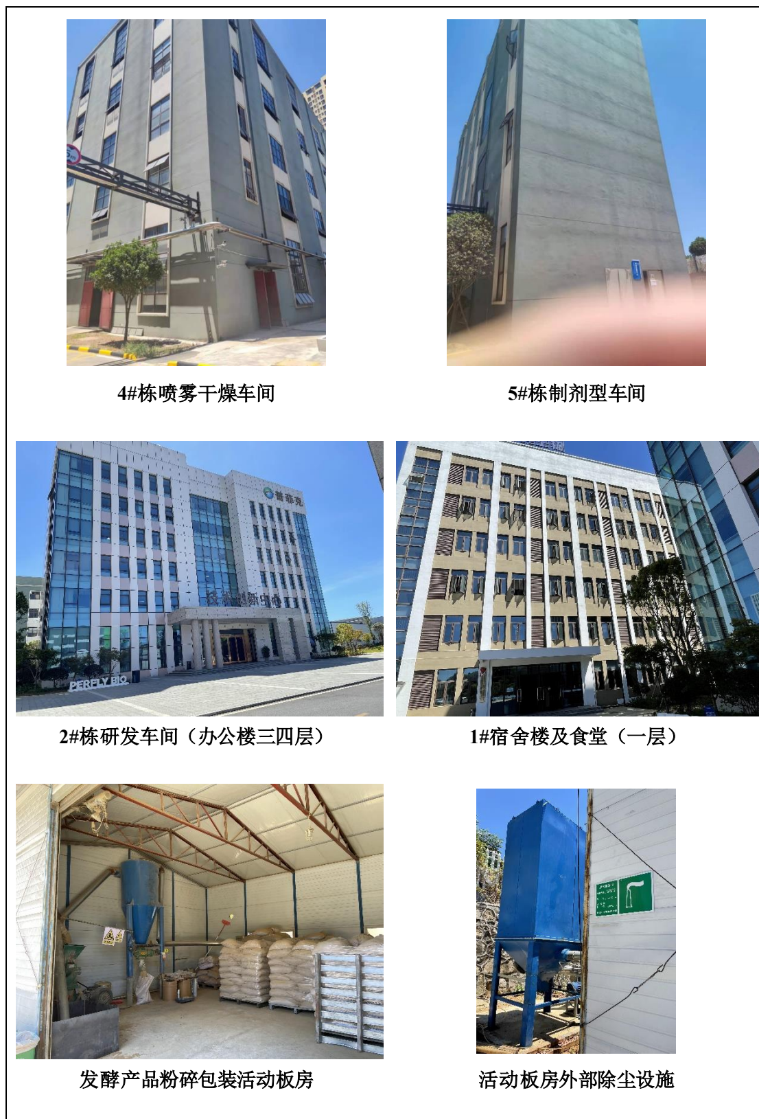
图 3.1.4-1 各生产厂房建设情况
